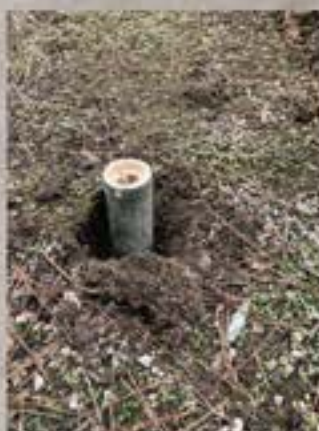
割竹挿入 土壌改善工法
